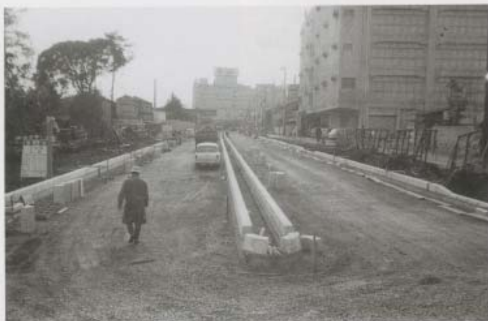
昭和46年●工事中のA道路
