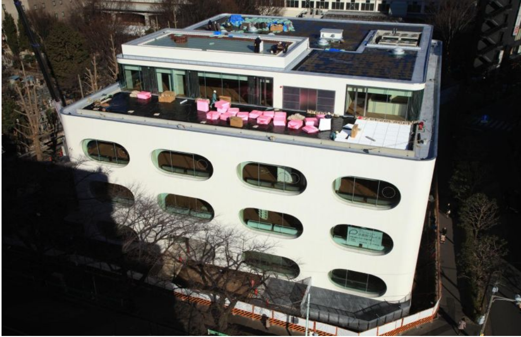
▲全景(南側より)
