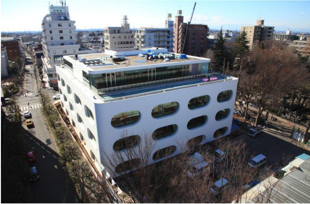
▲全景(北側より)
