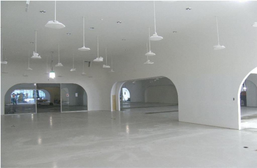
▲内装仕上工事 天井・壁 塗装完了 床施工前 状況
