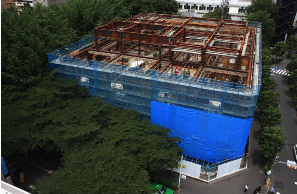
▲全景(南側より)
