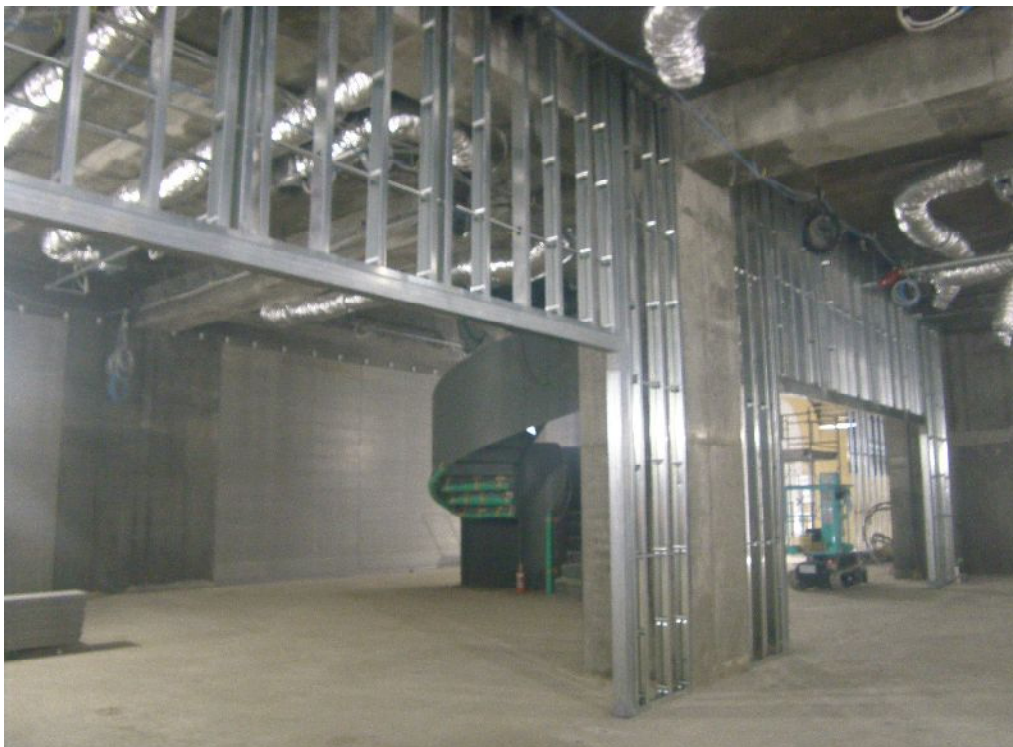
▲地下2階 内装区画間仕切等 施工状況
