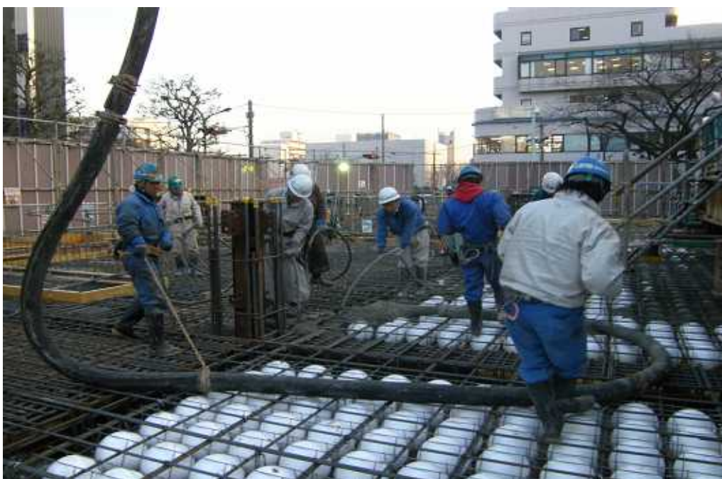
地下1階立上・1階スラブコンクリート打設状況
