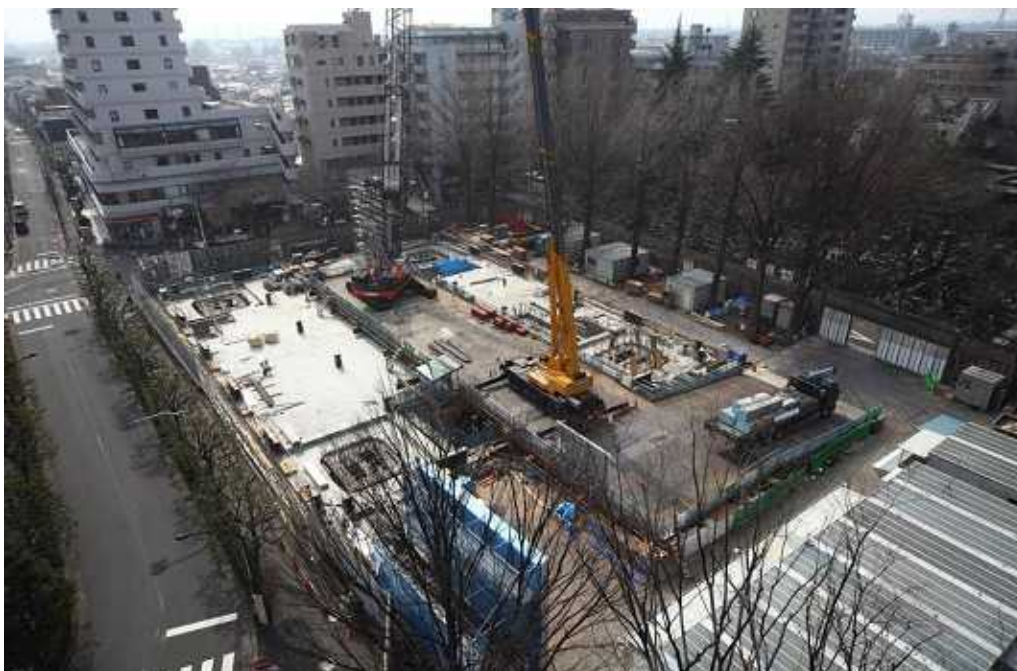
全景(北側より)
