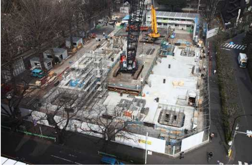
全景(南側より)
