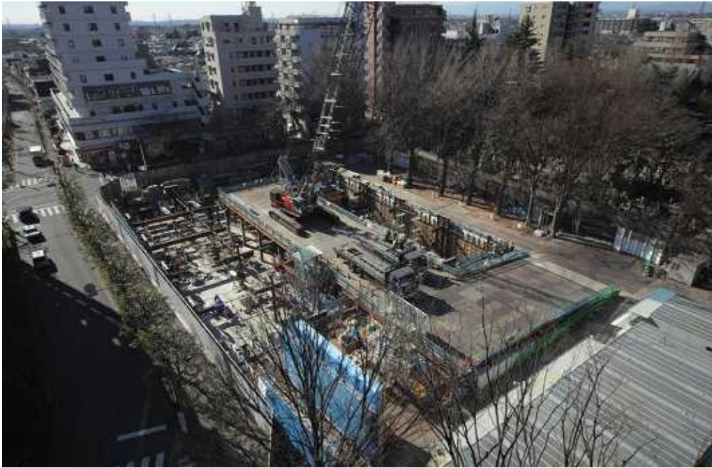
全景(北側より)
