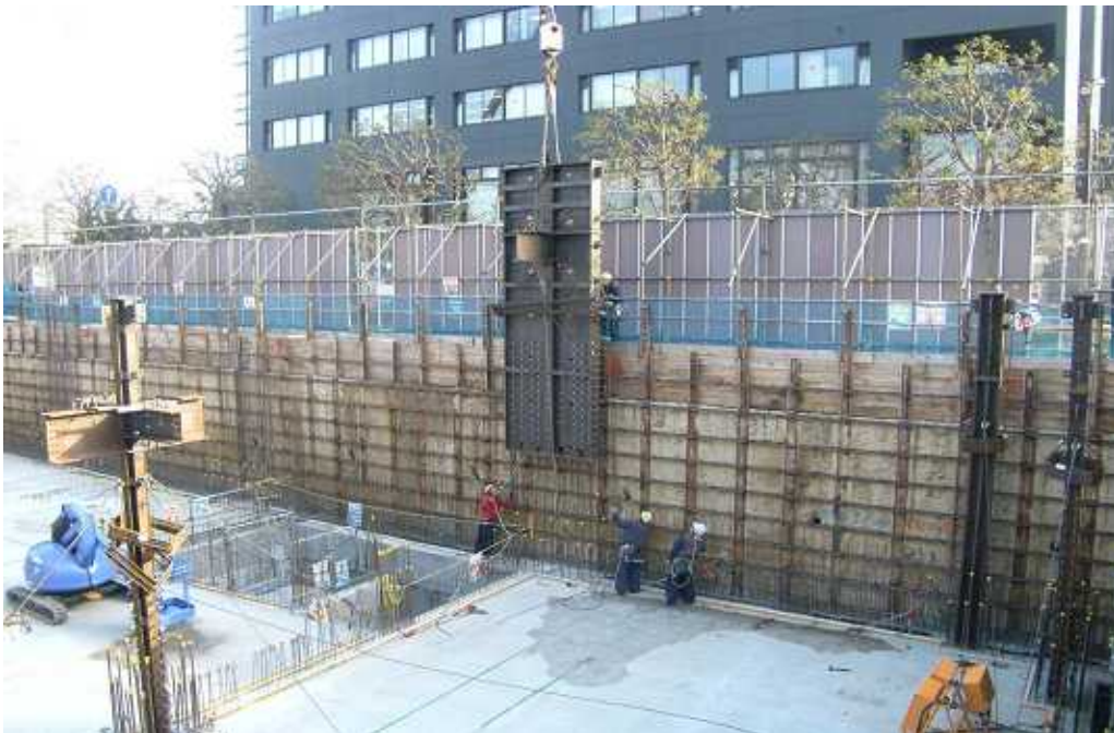
地下1階 0節 鉄骨建方状況
