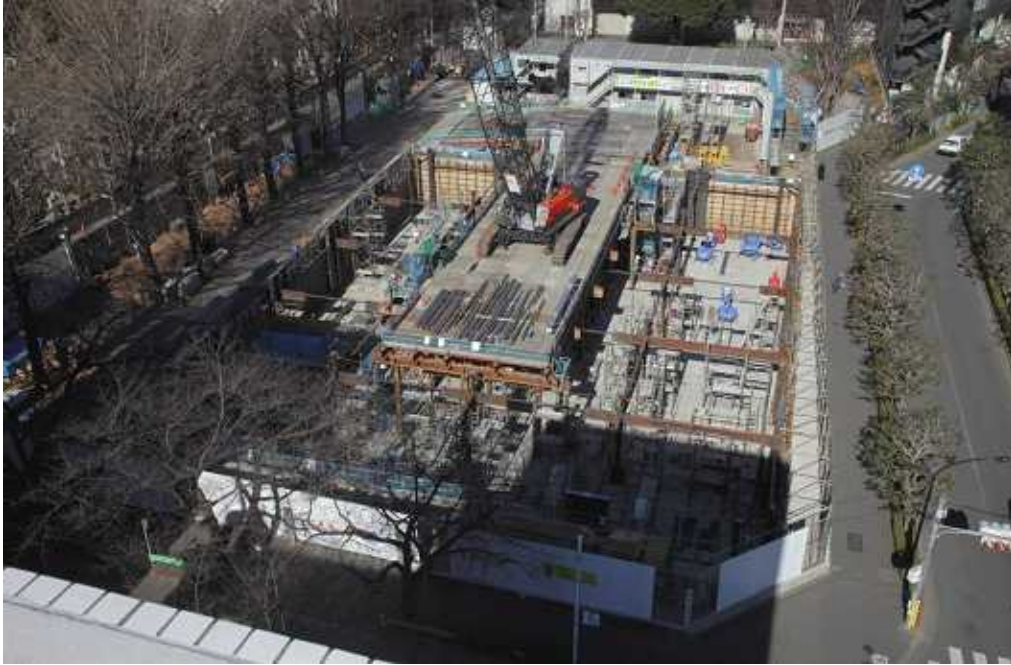
全景(南側より)
