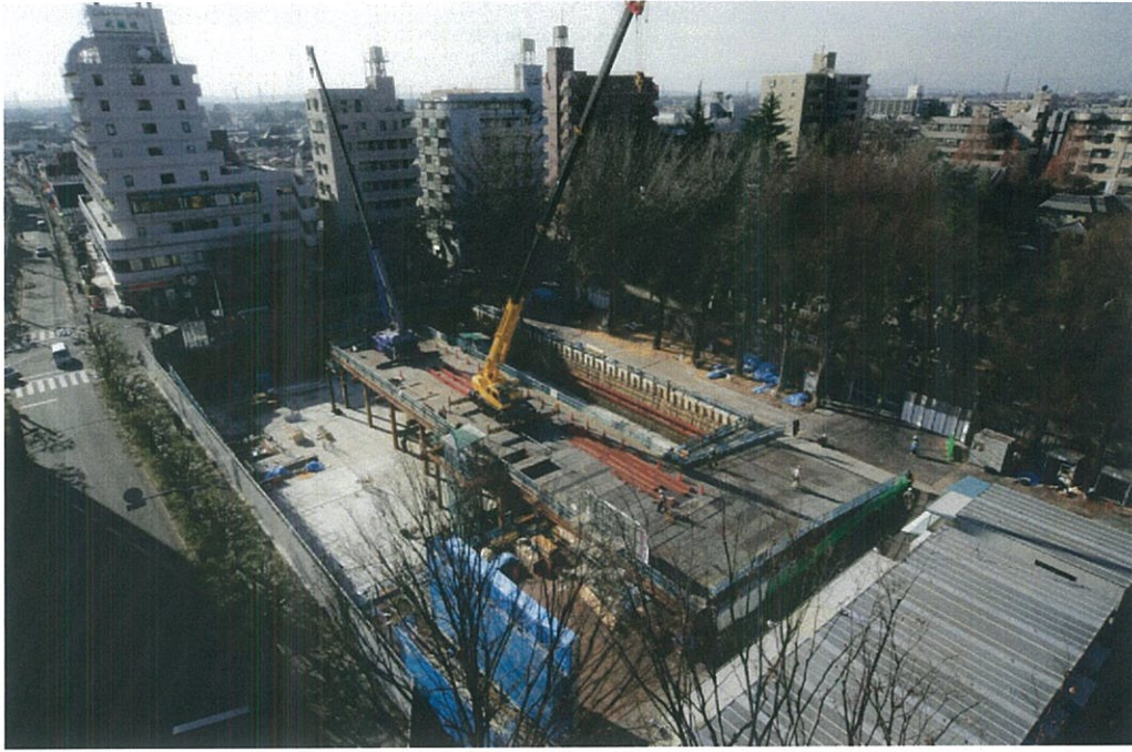
▲全景(北側より)
