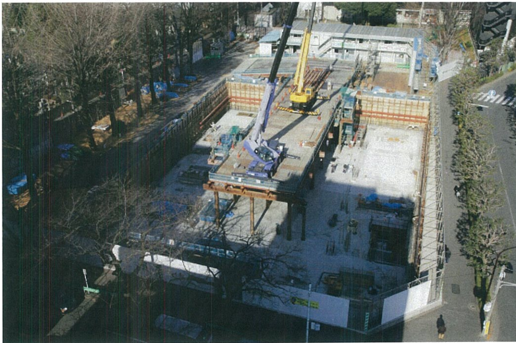
▲全景(南側より)
