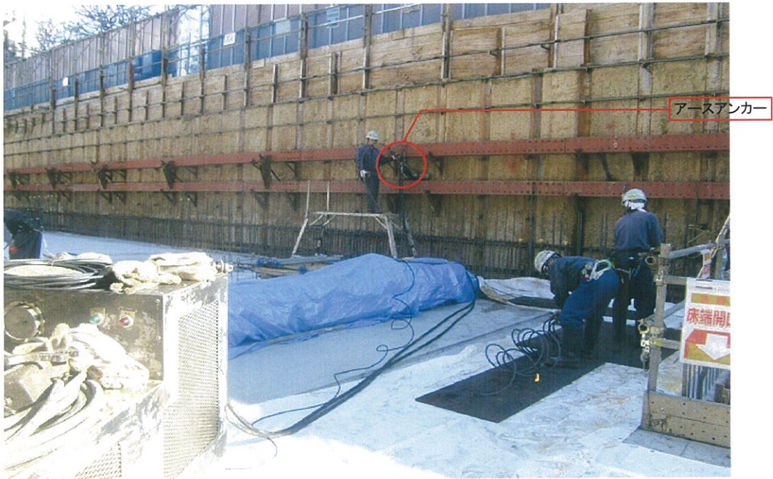
▲地下1階 1段目アースアンカー撤去状況
