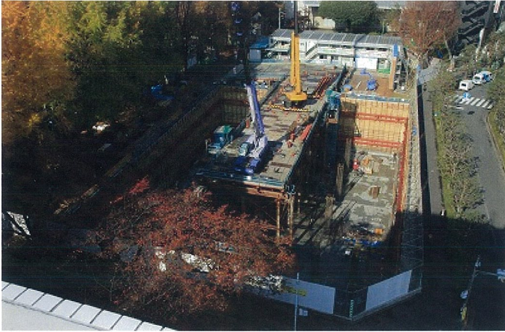
▲全景(南側より)
