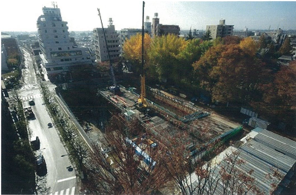
▲全景(北側より)
