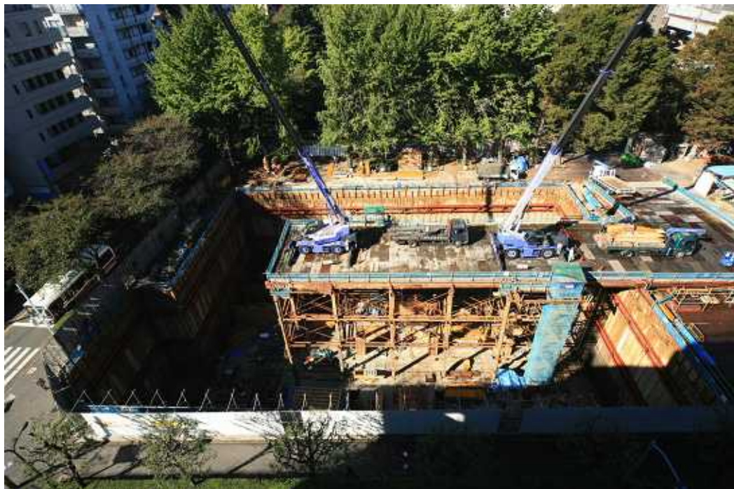
全景(東側より)
