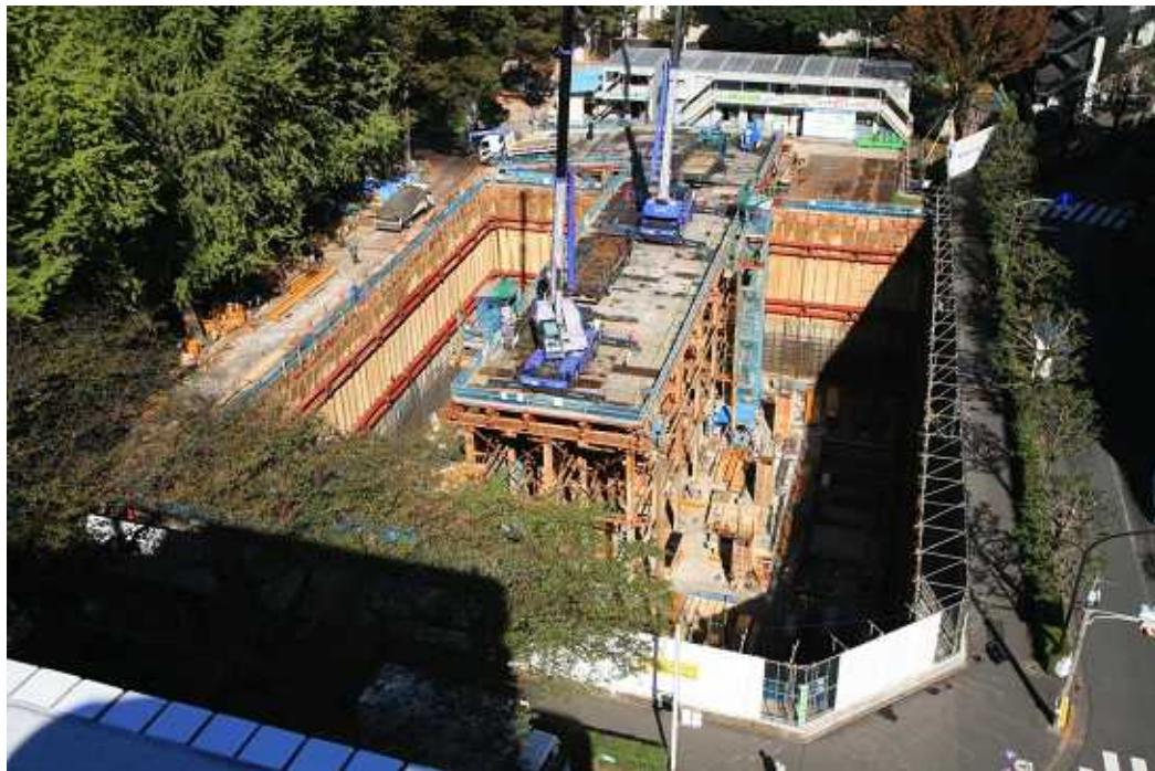
全景(南側より)
