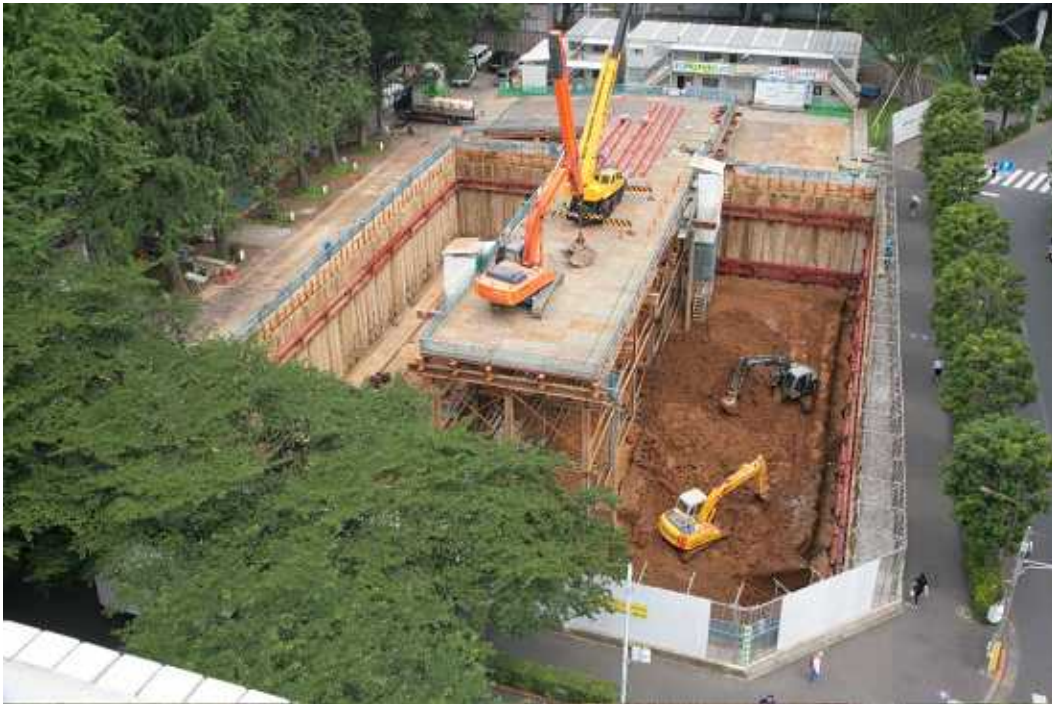
全景(南側より)
