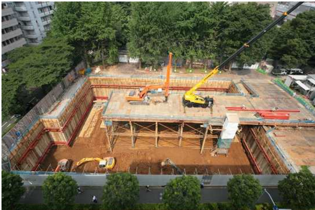
全景(東側より)
