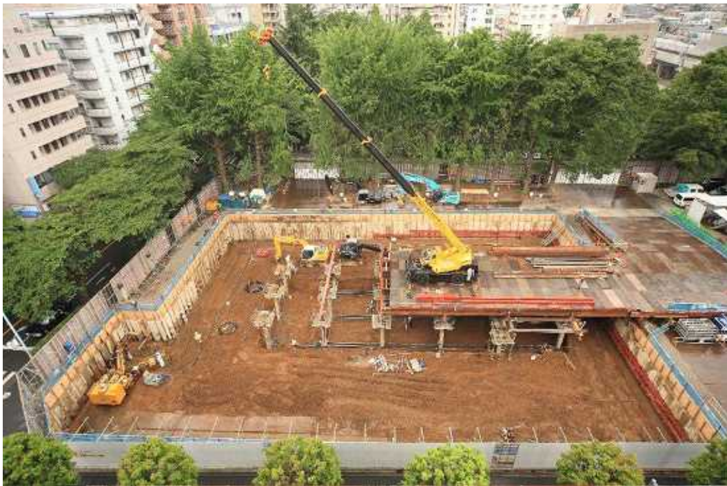
全景(東側より)
