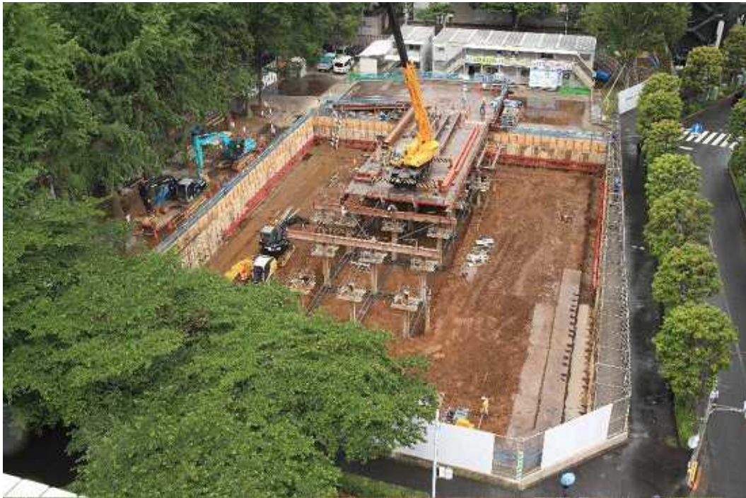
全景(南側より)
