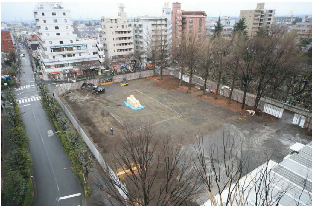
▲全景(北側より)
