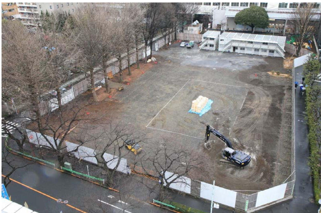
▲全景(南側より)
