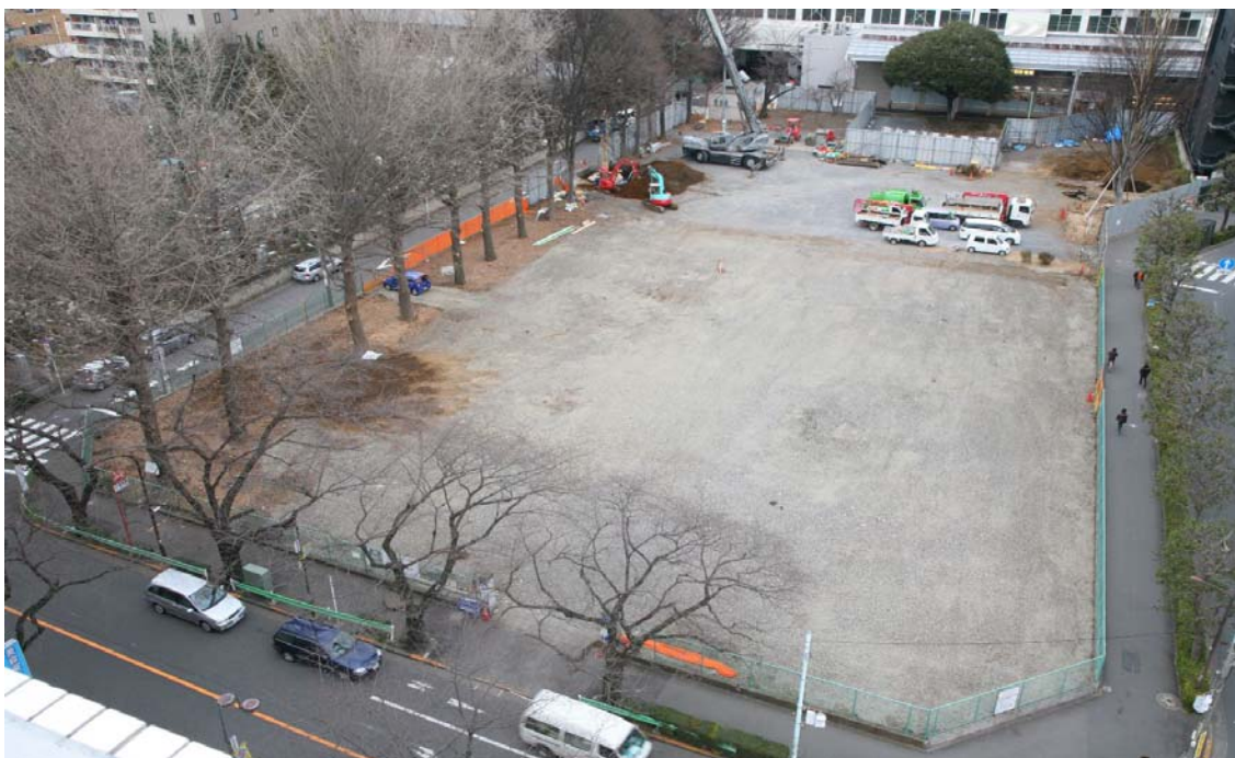
▲全景(南側より)
