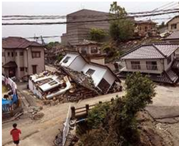
熊本地震による建物倒壊事例 (出典：内閣府)
