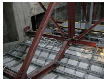
耐震化された天井
