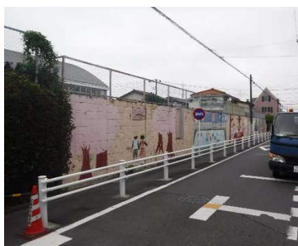
図5-4 改修前のブロック塀
