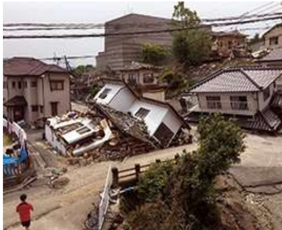
図 1 - 1 熊本地震による建物倒壊事例 (出典：内閣府)
