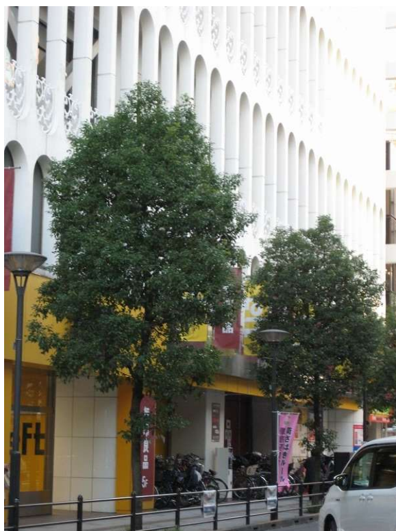
図2-3 耐震改修が終了した大規模建築物の事例
