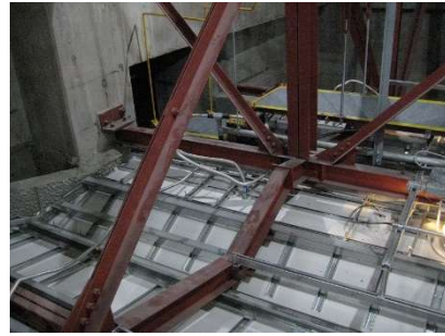
図 2 - 11 耐震化された天井
