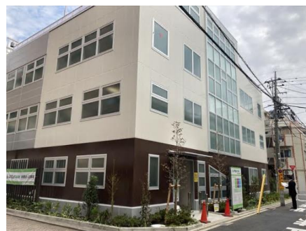
▲歩行者と自転車の輻輳を回避した配置を行った 吉祥寺クックロード自転車駐車場(武蔵野市)
