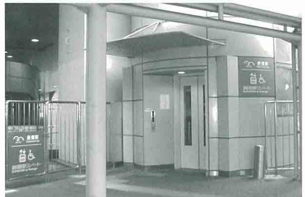
改札の外側に設置されたエレベーターの例 (ゆりかもめ 新橋駅)
