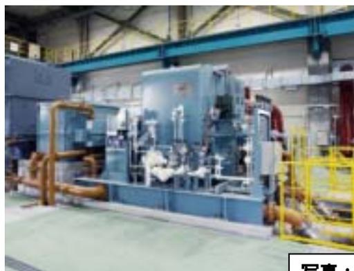
写真：ごみ発電/蒸気タービン
