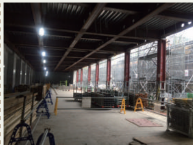
地下1階プラットホームの様子
