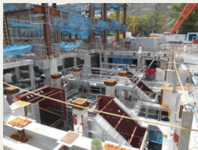
焼却炉地下部分の組み立ての様子
