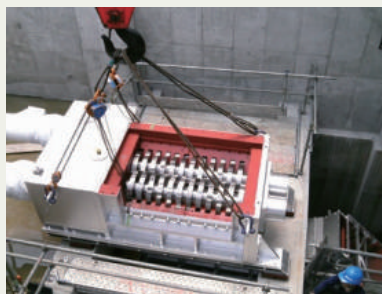
破砕機設置の様子
