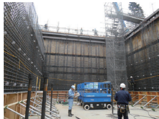
建設中のごみピット
