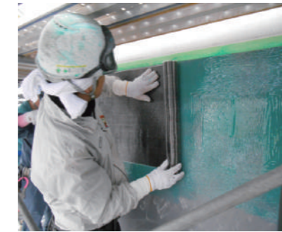
炭素繊維シート巻付けの様子
