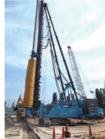
SMW (遮水壁) 施工の様子
