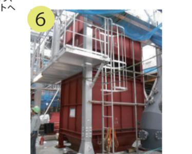
6 エコノマイザーを設置しました。蒸気は蒸気タービンを通り、水に戻り、エコノマイザーを通して温水となり、ボイラドラムに戻ります。
