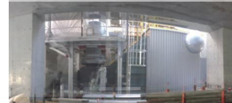
常用ガスコージェネレーション設備設置状況。
