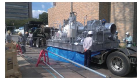
蒸気タービン発電機搬入の様子。
