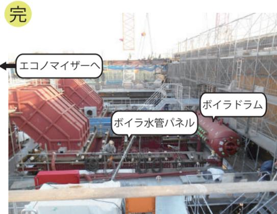
完 エコノマイザーへ ボイラ水管パネル ボイラドラム
