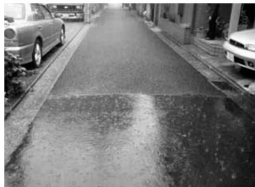
透水性舗装の整備を行い、雨水浸透の促進や都市型水害の軽減を図っています。
