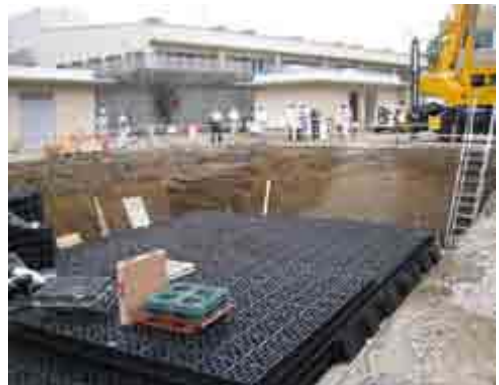
雨水貯留浸透施設
