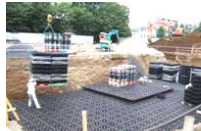
雨水貯留浸透施設
