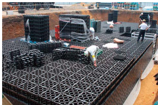
雨水貯留浸透施設
