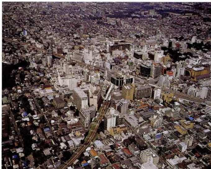
都市インフラの安全性の再点検が必要です。
