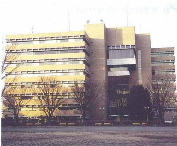
武蔵野市庁舎
