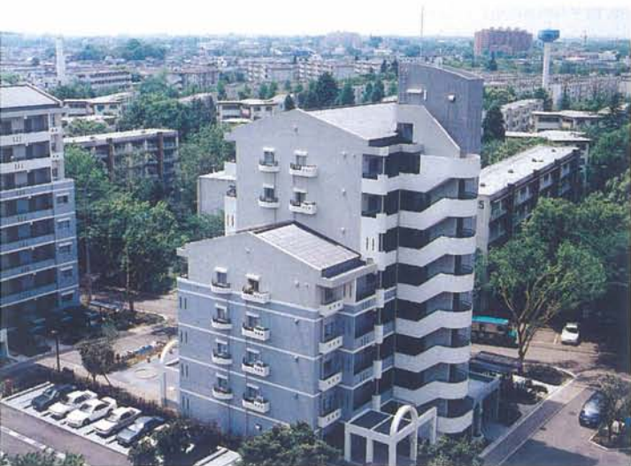
緑町住宅団地
