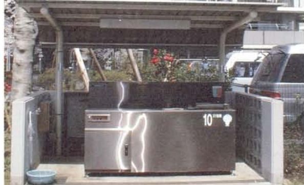
桜堤団地に13台の大型生ごみ処理機が設置されました。
