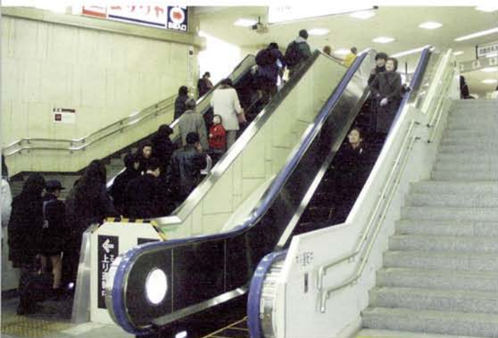
移動にやさしい駅構内の上下エスカレーター
