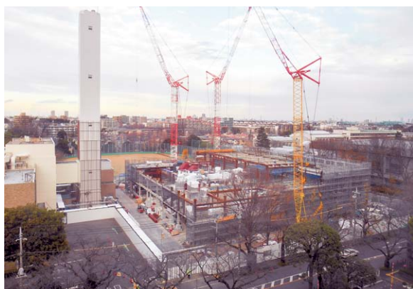
建設中の新クリーンセンター
