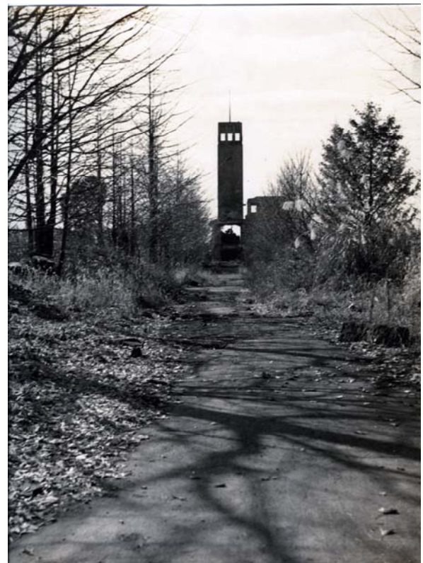
廃墟となった中島飛行機武蔵製作所時計台 (昭和26年 中村正英氏撮影)
