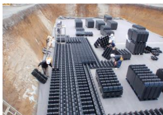
透水性シートの上に、プラスチック製の製品を並べて貯留槽をつくり透水性の目詰まり防止シートで覆います。
