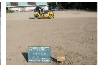
最後にグラウンドをきれいに舗装します。児童生徒のみなさんの運動はもちろん、5tトラックが上を走りまわっても平気です。
