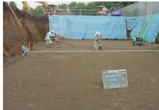
グラウンドを掘り、貯留浸透施設を設置するスペースを作ります。
