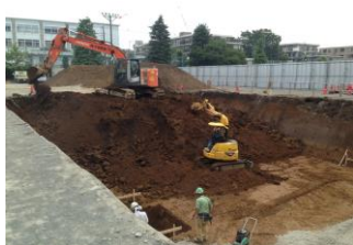
グラウンドを掘り、貯留浸透施設を設置するスペースを作ります。
