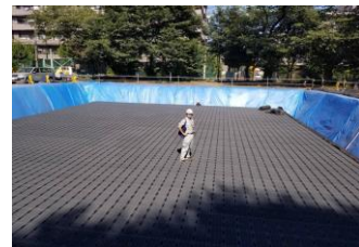
透水性シートの上に、プラスチック製の製品を並べて貯留槽をつくり透水性の目詰まり防止シートで覆います。
