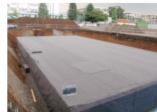
透水性シートの上に、プラスチック製の製品を並べて貯留槽をつくり透水性の目詰まり防止シートで覆います。
