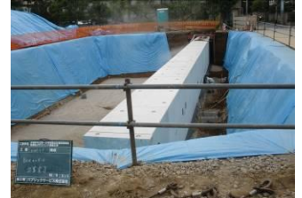
コンクリート製のボックスカルバートを並べて貯留浸透施設の点検孔をつくります。
