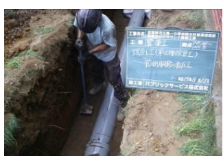
貯留浸透施設へ雨水を引き込む下水道管やマンホールを設置します。
