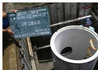
貯留浸透施設へ雨水を引き込む下水道管やマンホールを設置します。
