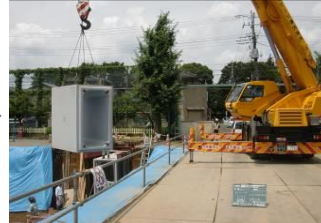
コンクリート製のボックスカルバートを並べて貯留浸透施設の点検孔をつくります。
