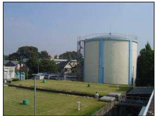
図4 配水池の外観
