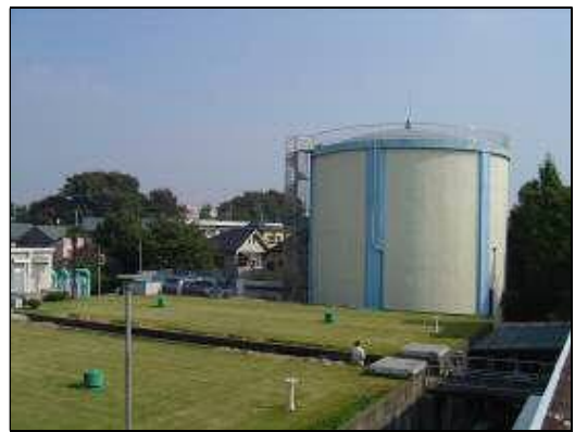
図4 配水池の外観
