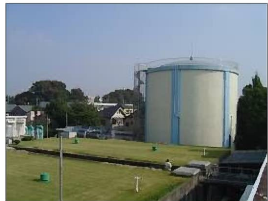
図4 配水池の外観
