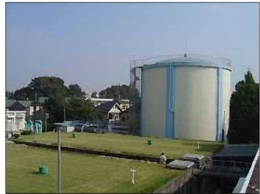
図4 配水池の外観
