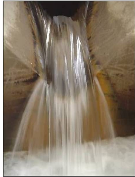
図2 浄水場に集まる深井戸の地下水
