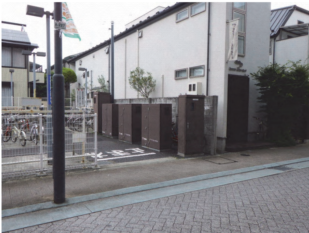
図3-21 地上機器の集中配置の事例（未広通り）
