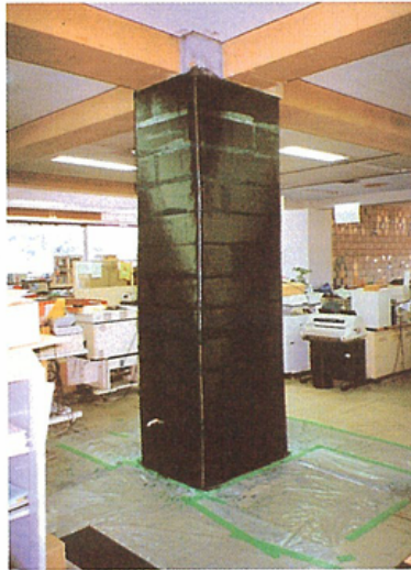
炭素繊維シート巻付け終了
