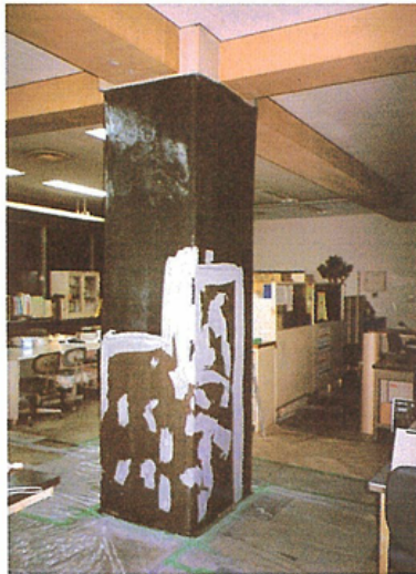
パテ処理プライマー塗布状況
