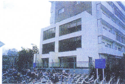
改修によって、1階と2階にバットレスを取り付けた
