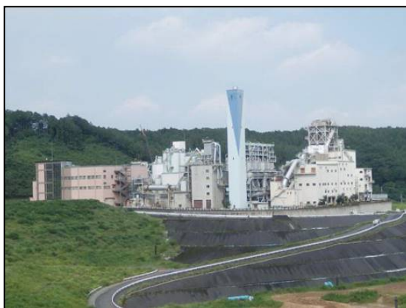
エコセメント化施設の全景
