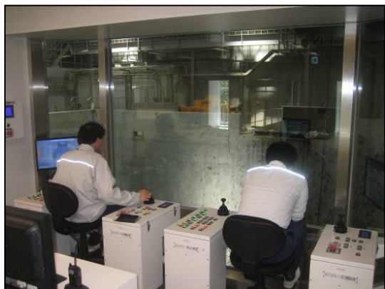
クレーン操作の様子
