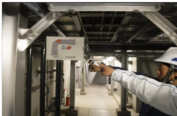
薬品漏えい対応訓練状況
