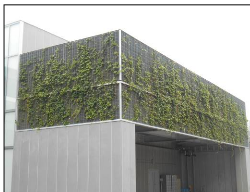
管理棟の壁面緑化
