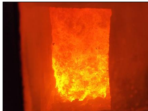
焼却炉内の様子
