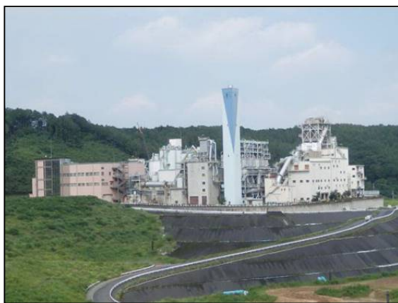
エコセメント化施設の全景
