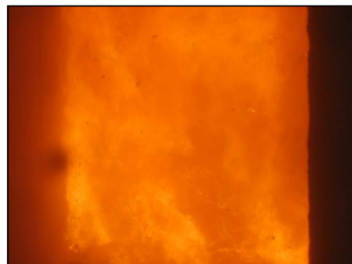
焼却炉内の様子
