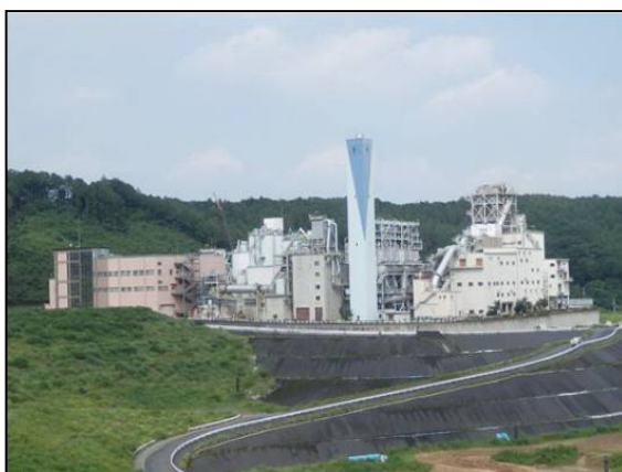
エコセメント化施設の全景
