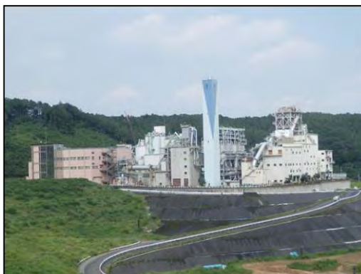
エコセメント工場全景
