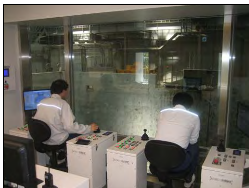
クレーン操作の様子
