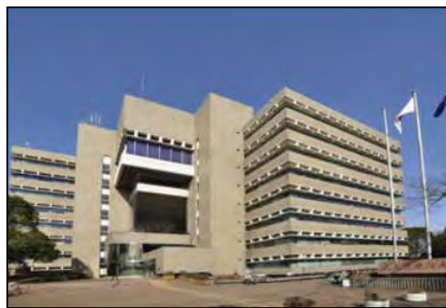
武蔵野市庁舎
