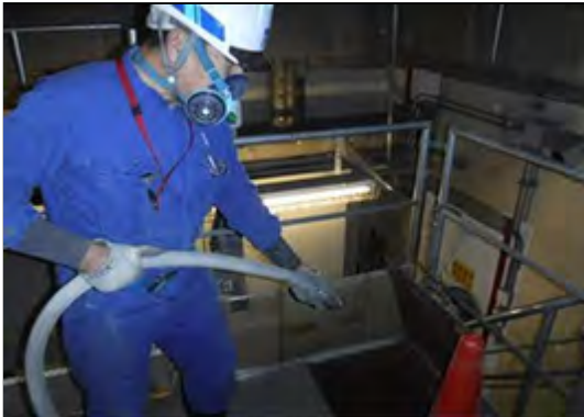
鉄ホッパーの消火訓練状況
