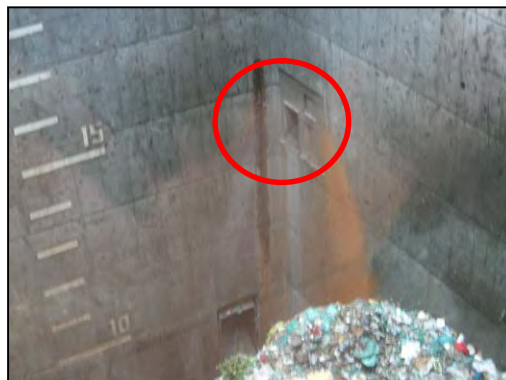
可燃ごみピットの落ち口
