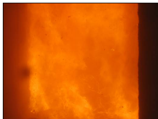
焼却炉内の様子
