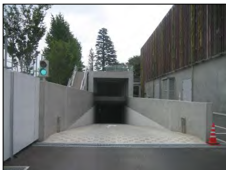
地下1階プラットホームへと続くスロープ
