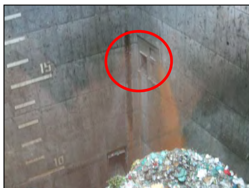
可燃ごみピットの落ち口
