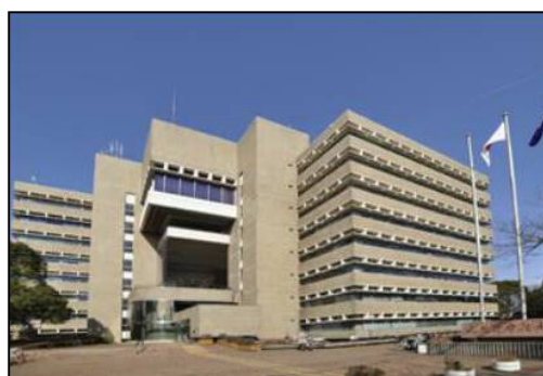
武蔵野市庁舎
