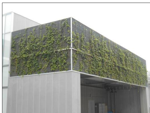
管理棟の壁面緑化
