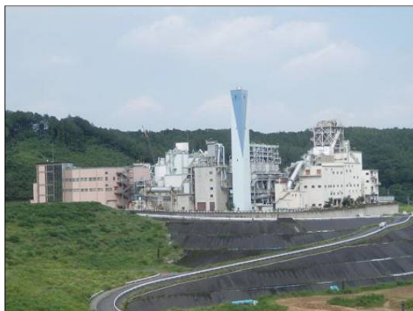
エコセメント化施設の全景
