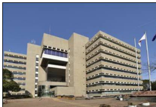
武蔵野市庁舎
