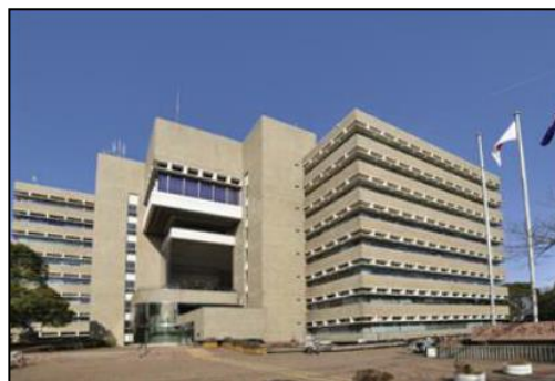
武蔵野市庁舎
