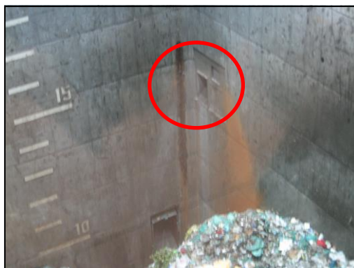
可燃ごみピットへ運ばれる可燃性の不燃ごみ
