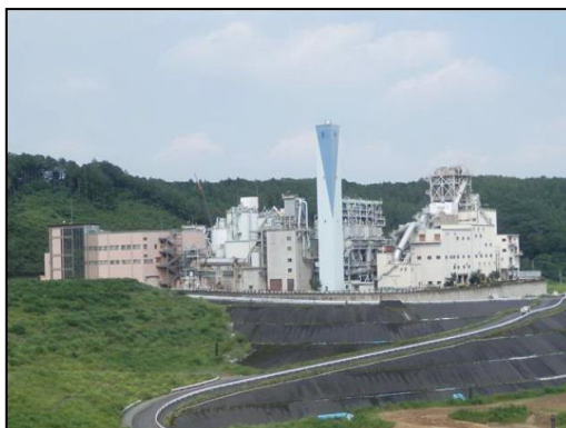
エコセメント工場全景
