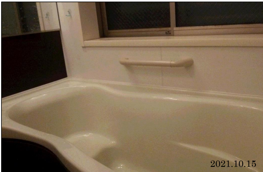
② 浴室 手すりの取付け
