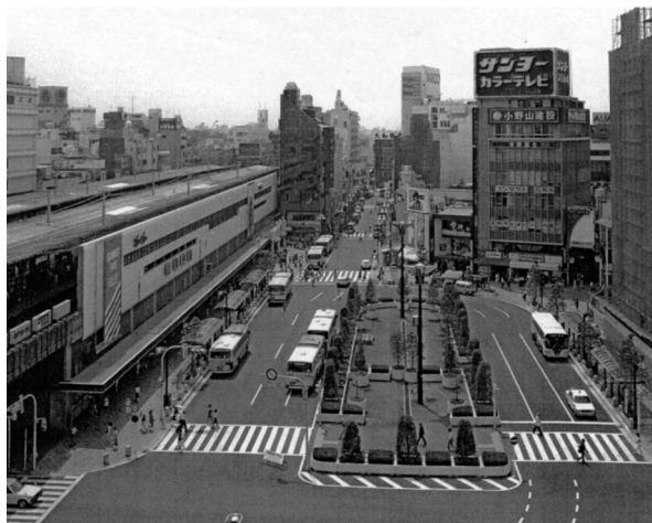
昭和62年3月に完成した吉祥寺駅北口広場
