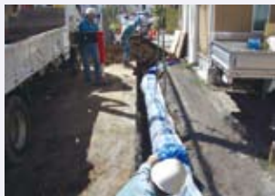
配水管の布設替え工事の様子
